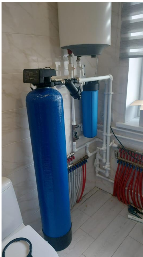
Рис. 12. Система водоочистки в загородном доме (1 – дисковый фильтр, 2 – фильтр обезжелезиватель, 3 – фильтр ВВ-20 с сорбционным угольным картриджем)
